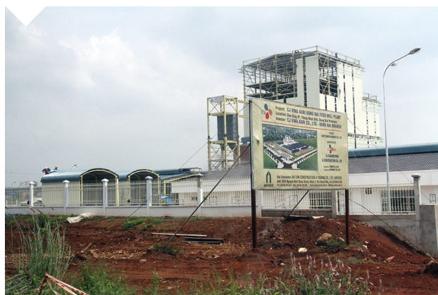
Usine d'aliment pour bétail en construction à Đồng Nai
