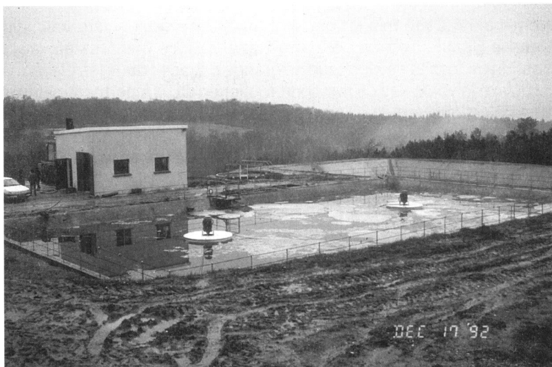
Photo 10 : L'élimination poussée de l'azote et l'exportation du phosphore : l'installation Ternois Épuration à Castelnaudary (à la C.A.L.). (photo CEMAGREF, J. Coillard)
