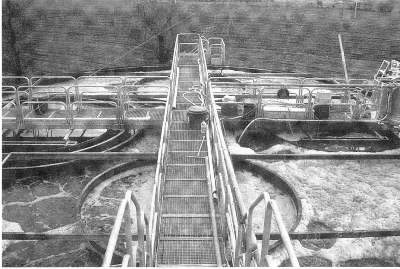
Photo 9 : L'élimination poussée de l'azote : le procédé AGROCLAR. (photo CEMAGREF, J. Coillard)
