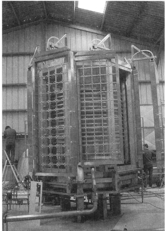
Photo 12 : Le traitement collectif : le procédé thermique SIRVEN. (photo CEMAGREF, J. Coillard)
