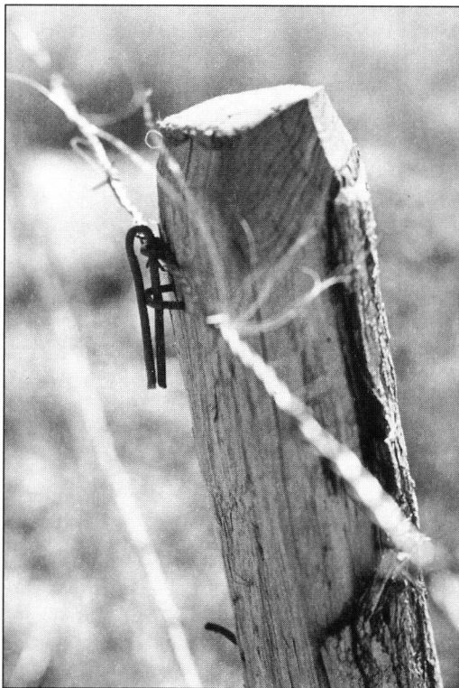
Photo 13. Système de fixation pour pose et dépose des fils barbelés.
