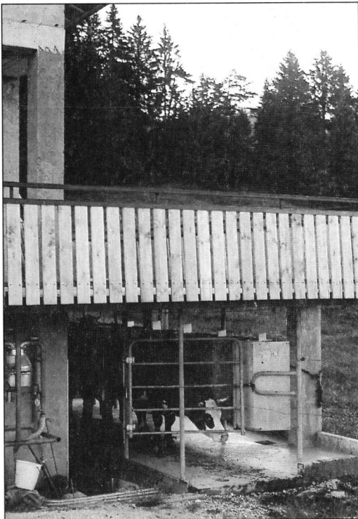
Photo 4. Aménagement d'une salle de traite sous un balcon, une solution économique et fonctionnelle.
