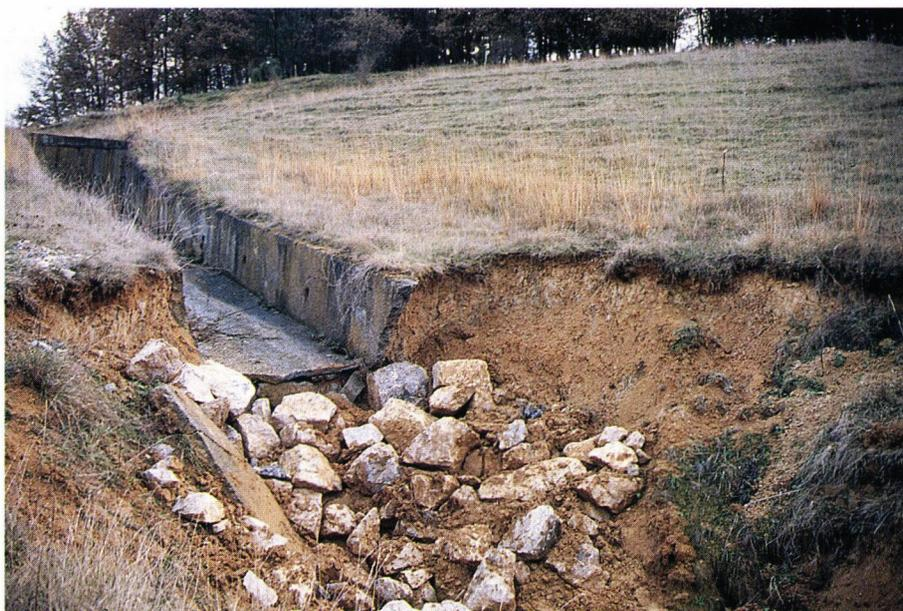
L'absence de dissipateur d'énergie à l'aval de ce coursier bétonné provoque une grande fosse d'érosion. Celle-ci progresse vers l'amont, selon le mécanisme de l'érosion régressive ; elle risque à terme d'évoluer vers un contournement complet du barrage.
