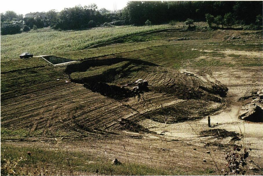
Glissement du talus amont d'un barrage en terre de 17 m de hauteur. Cet incident est survenu lors de la quatrième vidange de la retenue destinée à l'irrigation. On notera la progression du phénomène démarré à la base du talus et qui s'est stabilisé à l'aplomb du seuil déversant.
