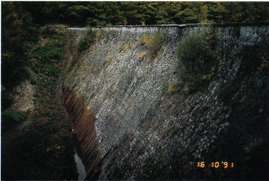
Ce barrage à vocation industrielle construit en 1909 (15,5 m ; 200 000 m<sup>3</sup>) n'a plus d'utilité. Assez délabré, il est dangereux et doit être rendu transparent.
