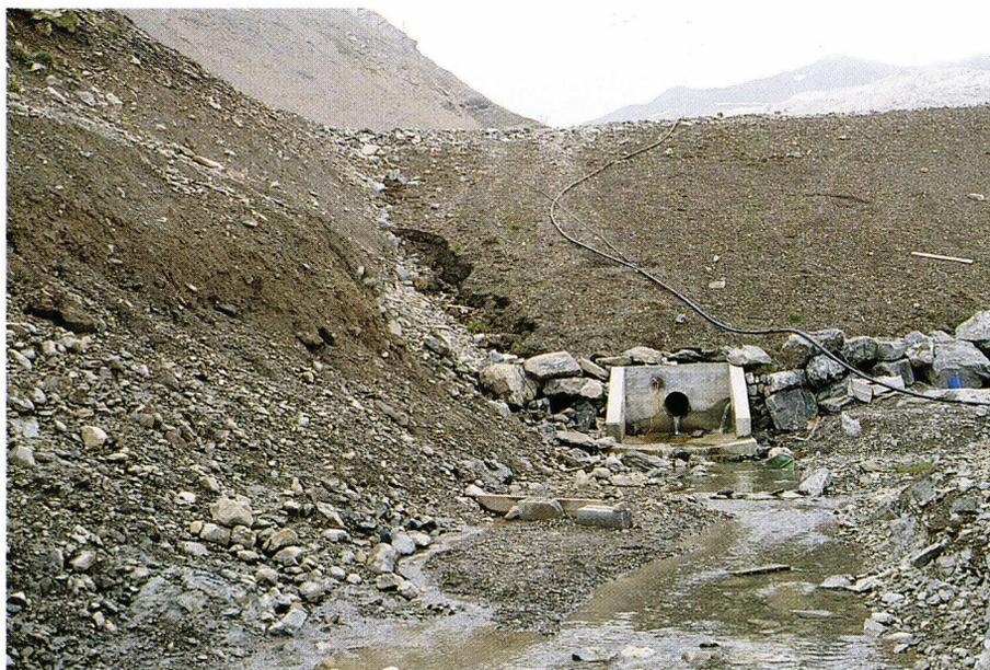
Fuite par l'appui rive droite de ce barrage alpin de hauteur 7,5 m. L'appui est une moraine qui a été mal injectée. Les risques sont de voir cet incident évoluer en renard, ou bien entraîner un glissement du talus aval.
