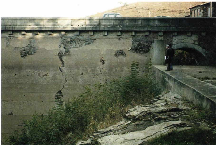
Etat très dégradé du masque amont de ce barrage construit en 1870 et destiné à l'AEP. La capacité du déversoir de crue est insuffisante. La décision de le réhabiliter ou de le rendre transparent reste à prendre.
