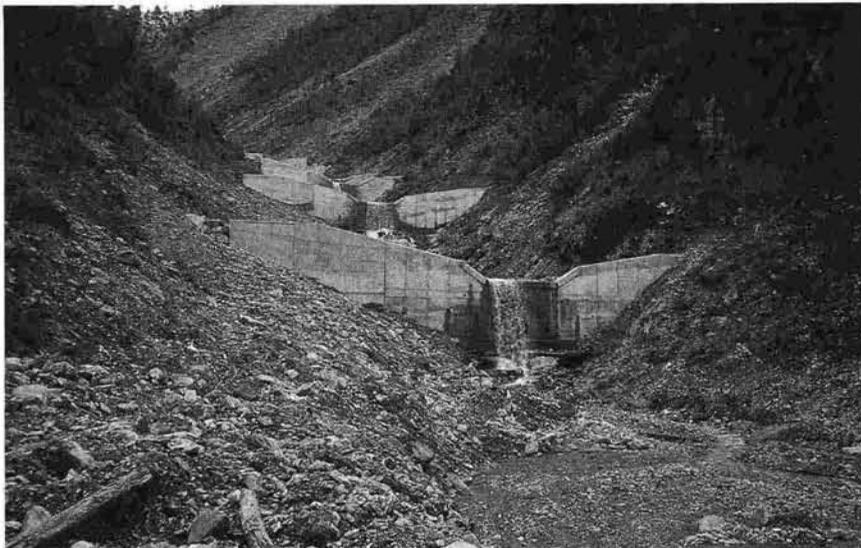
photo 1.1 : aménagement par barrages de consolidation
