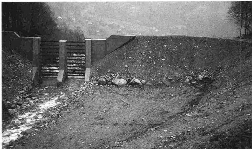
photo 4.1 : grilles métalliques à barres horizontales
