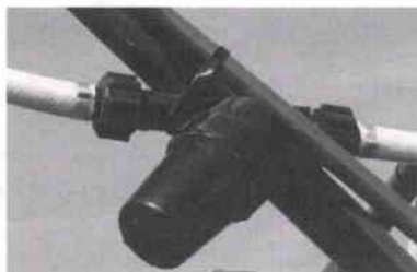
Fig. 195b - Vue d'un filtre de rampe (photo Cemagref)
