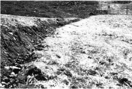
La construction des revers d'eau en travers des pentes doit s'accompagner de la modification des collecteurs et des exutoires, car il faut que ces ouvrages soient capables d'absorber correctement les apports d'eau supplémentaires, sans déplacer vers l'aval les risques d'érosion.
