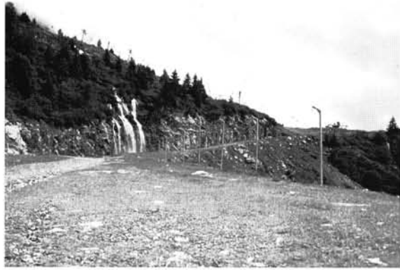
Piste végétalisée 1 an après le semis
