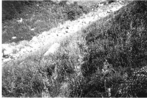
Végétation installée après le semis
