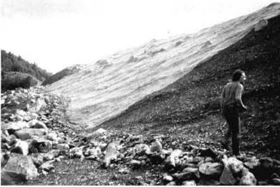
Toile de jute en cours de pose
