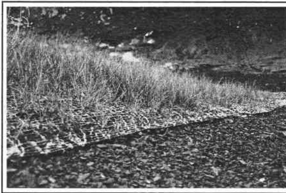
Photo 3 - Engazonnement sous toile en versant nord (2 ans après le semis)
