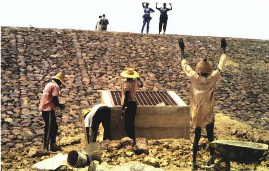
*Photo 3.4 : Un perré amont en blocs de latérite rangés à la main. Remarquer au premier plan le puisard de l'ouvrage de prise (commande aval).*
