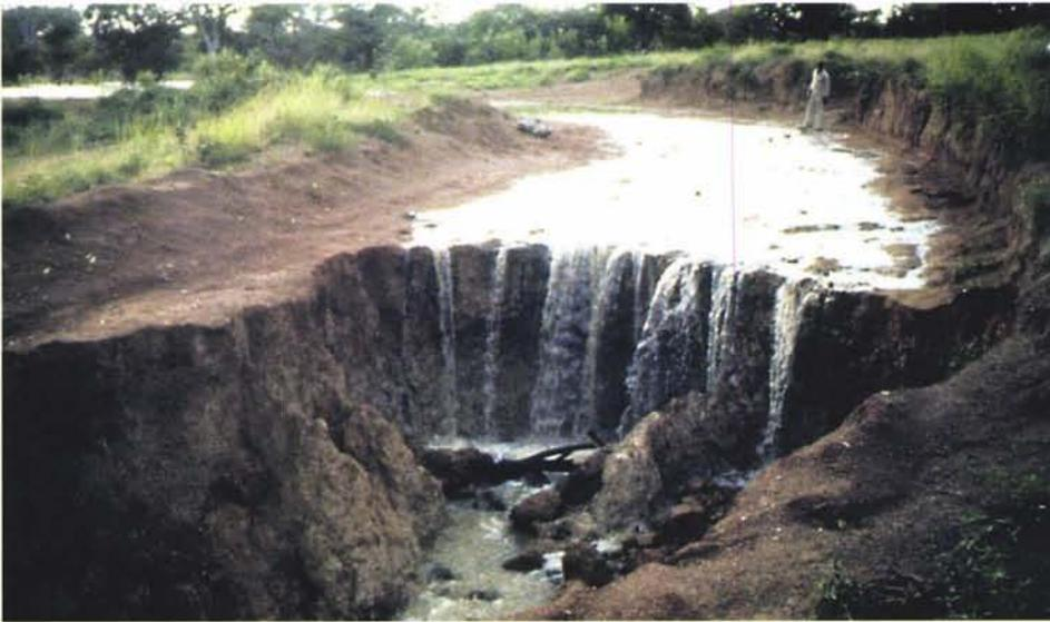
*Photo 2.3 : Phénomène d'érosion régressive dans un chenal non revêtu placé à l'aval d'un déversoir frontal rejeté en rive*
