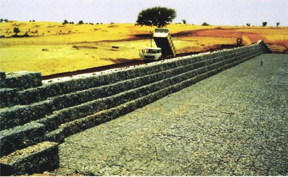
*Photo 5.1. : Barrage en gabions à parement aval vertical de Saouga 1 (Burkina faso).*
