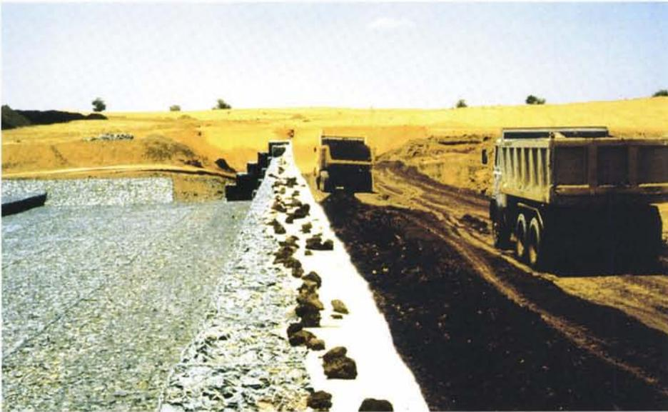
*Photo 5.2 : Barrage de Saouga 1 : Vue du chantier ; remarquer le géotextile en attente le long du mur vertical en gabions.*
