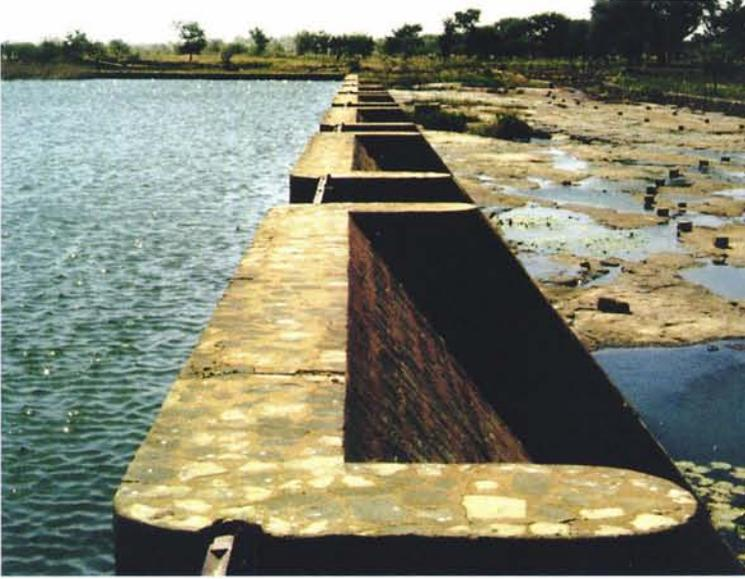
*Photo 4.2. : Barrage de Tégourou (Mali). Ouvrage muni d'une série de pertuis à batardeaux .*
