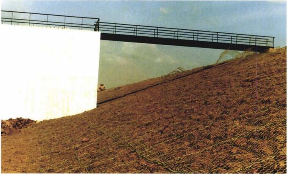
*Photo 5.4. : Vue de la protection en matelas Reno (fils revêtus de PVC) du parement amont du barrage d'Al Bassam de Niandouba (Sénégal).*
