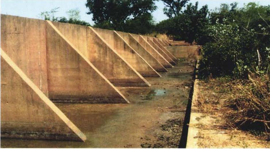
Photo 4.4. : Vue de l'aval du barrage-voile en béton armé à contreforts de Balavé (Burkina Faso).
