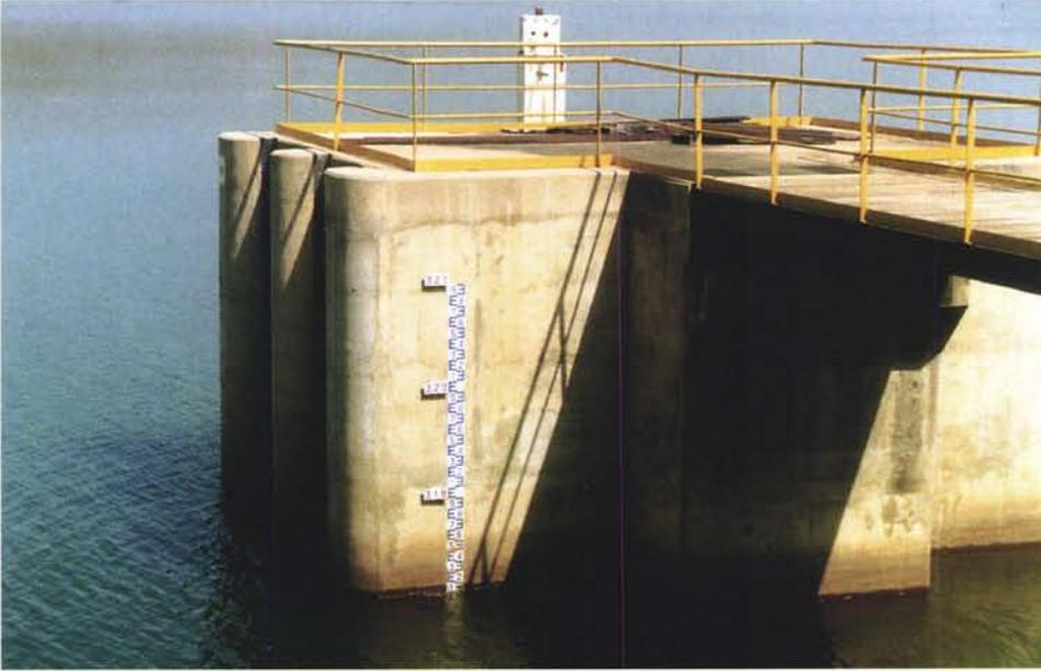
Photo 7.3 : Échelle limnimétrique installée sur une tour de prise (barrage de Douna - Burkina Faso).
