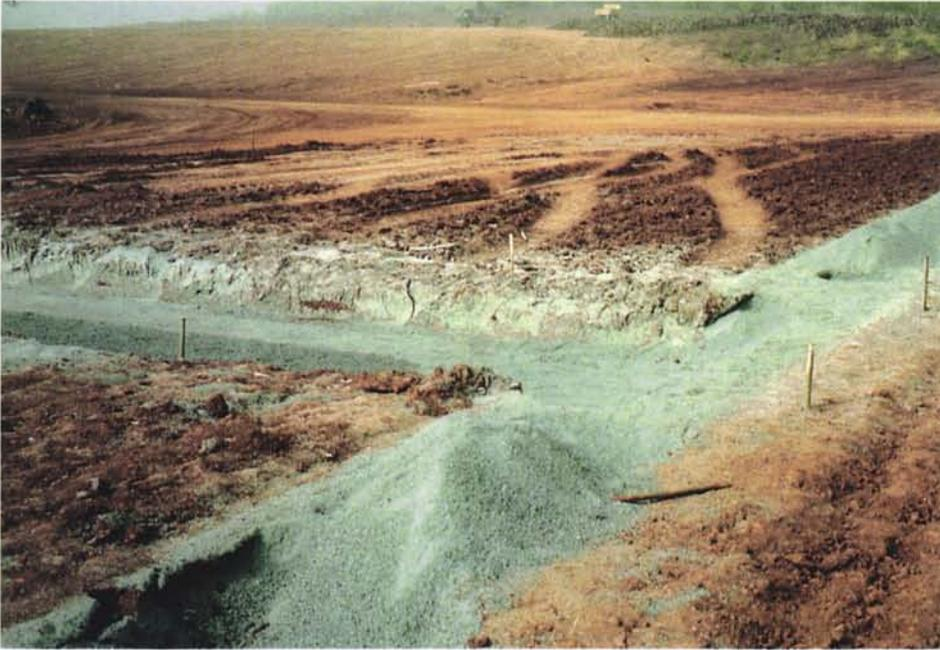
*Photo 3.1 : Confection d'un drain-cheminée (au premier plan) et d'une lanière drainante (au second plan) - Barrage de la Comoé (H = 20 m), Burkina Faso.*
