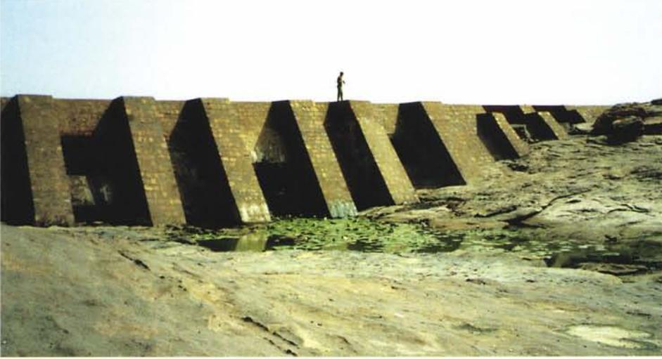
Photo 4.1 : Barrage en maçonnerie de Dobo 2 au Mali. Remarquer les pertuis de fond et de  $\frac{1}{2}$  fond.
