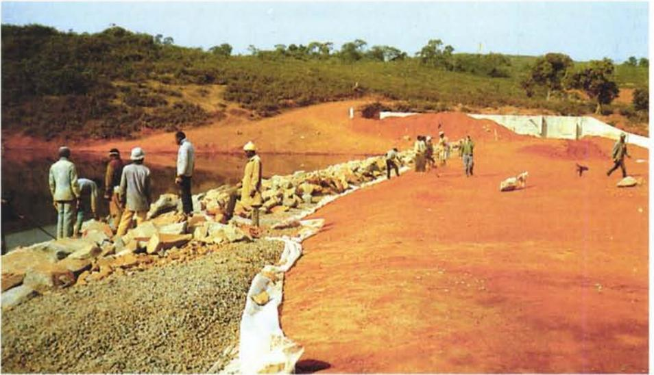
Photo 3.2 : Protection du talus amont du barrage de Dalaba (Guinée), de hauteur 12 m, par un rip-rap posé sur un lit de graviers et un géotextile. On aperçoit également au second plan le déversoir à entonnement latéral.
