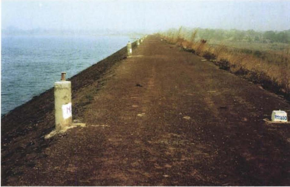
*Photo 7.6 : Protection de tête sur une ligne de piézomètres (remarquer également la borne pour le suivi topographique - Barrage de Douna - Burkina Faso).*
