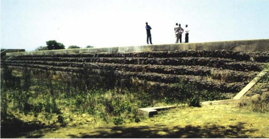
Photo 5.3 : Dissipateur en gradins de gabions disposé à l'aval d'un déversoir à seuil épais.
