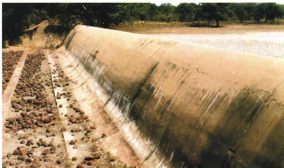
*Photo 2.2 : Barrage de Tia (Burkina Faso) ; déversoir-poids en béton à profil Craeger ; remarquer les nombreuses fissures et les problèmes de reprise de bétonnage ; noter également au second plan les gros arbres qui ont envahi le remblai.*
