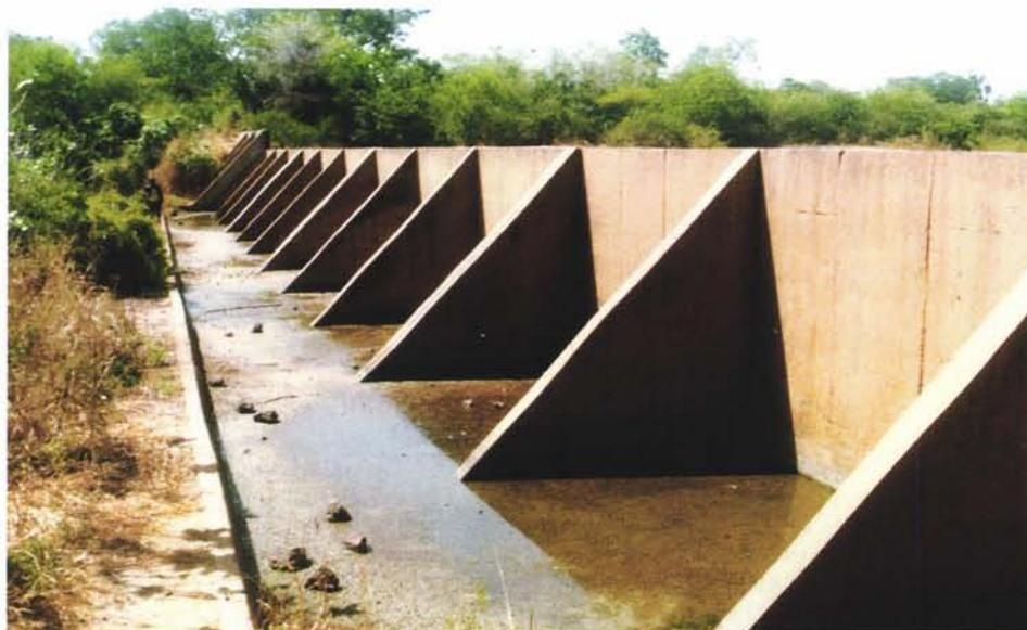
*Photo 1-D-1 : Vue générale de l'aval du barrage à contreforts de Balavé.*
