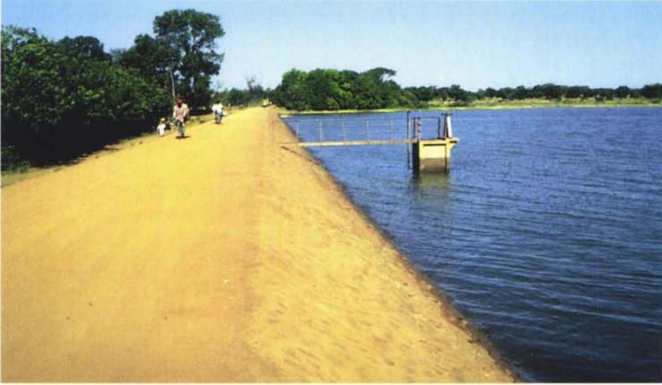
*Photo 3.3 : Protection d'un talus amont par un perré maçonné, réalisé à bain de mortier : une technique efficace, mais coûteuse. Remarquer également la protection de la crête, traitée selon les normes des pistes rurales, ainsi que la tour de prise (commande amont) - barrage de Donsin (Burkina faso).*
