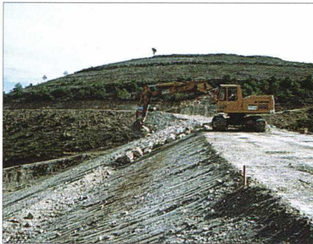
◀ 11 - Mise en place d'un revêtement antibattillage en partie supérieure d'un barrage à plan d'eau constant (texte p. 76).
