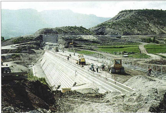
▼ 23 - Barrage en béton compacté au rouleau du Riou (texte p. 118 et coupe type p. 130).
