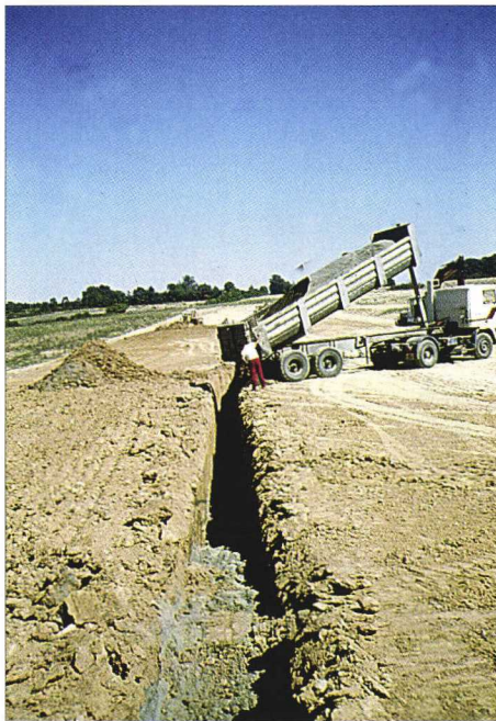
◀ 2 - Drain vertical recrusé dans le remblai et remplissage par du sable drainant et autofiltrant (texte p. 78).
