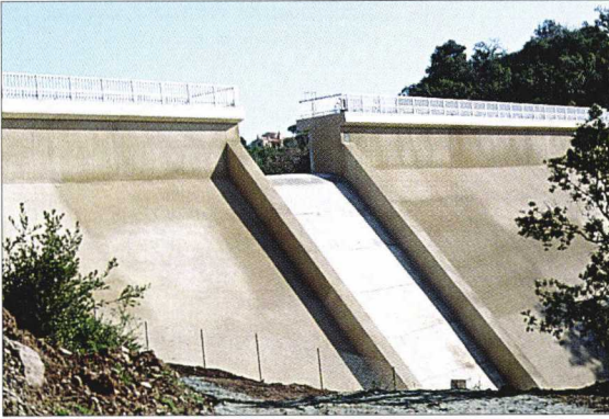
◀ 21 - Barrage poids en béton (texte p. 116).
