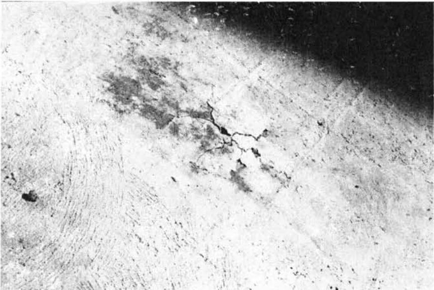
*Photo 5 : Barrage du Rouchain - Fissuration au droit d'un ancrage de la protection de la membrane*
