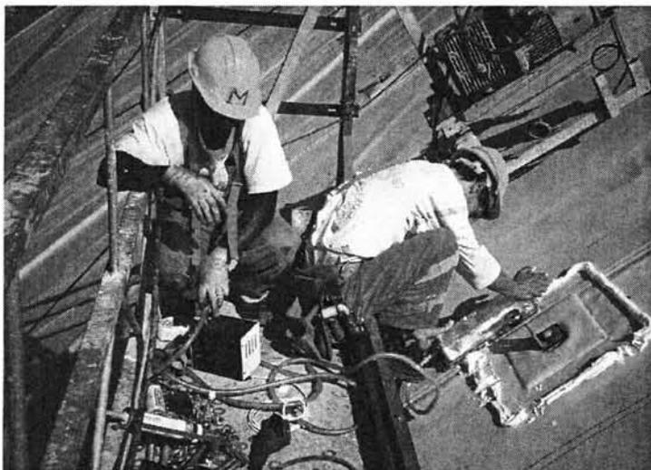
*Photo 4 : Barrage du Rouchain - Essai d'étanchéité des soudures autour d'un ancrage de la protection en béton armé*
