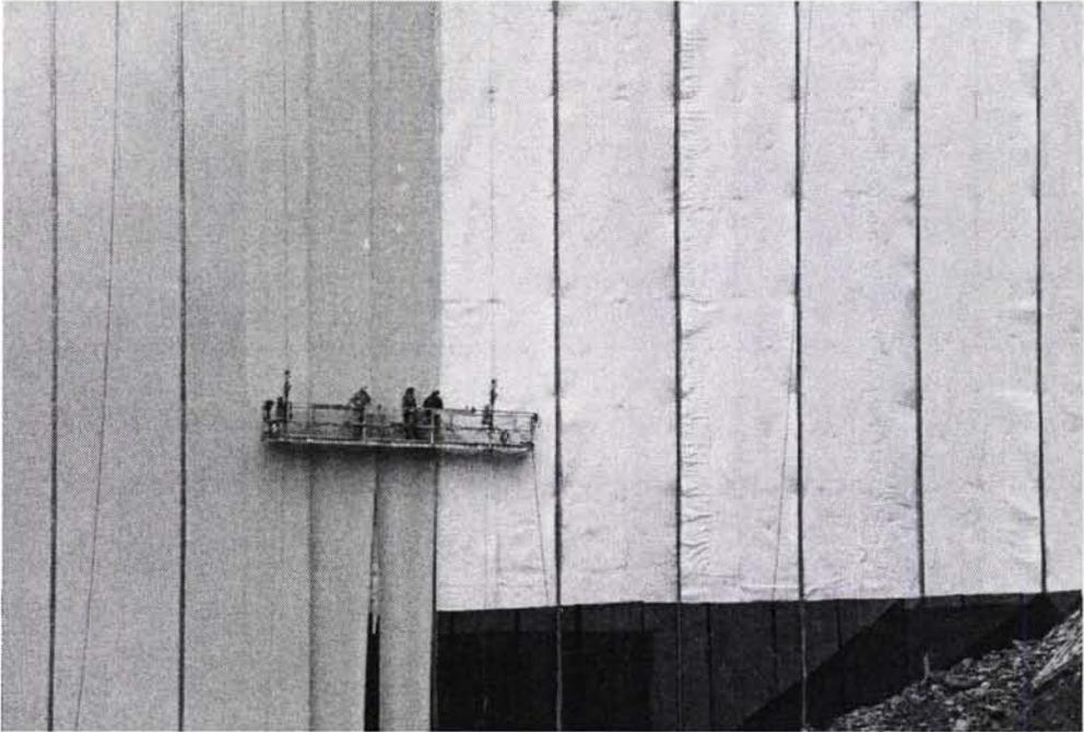
*Fig. n°3 : Mise en œuvre de la géomembrane. En blanc le géotextile, en noir la géogrille et en gris la membrane PVC*
