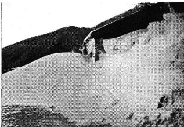
Photographie 5 : congère générée par un bâtiment (cliché F.Ousset/Cemagref)
