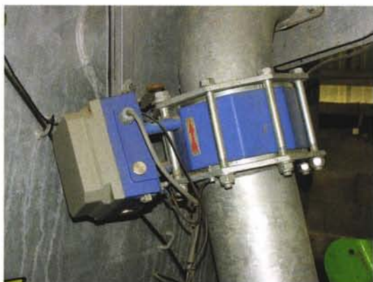
Photo 2.1 – Débitmètre à induction électromagnétique [F. Chabot, Cemagref]
