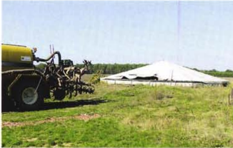
Photo 1.4 – Fosse à lisier de canards. Une couverture permet d'éviter la volatilisation d'ammoniac et la propagation d'odeurs. [F. Chabot, Cemagref]
