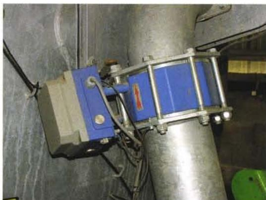
Photo 2.1 – Débitmètre à induction électromagnétique
