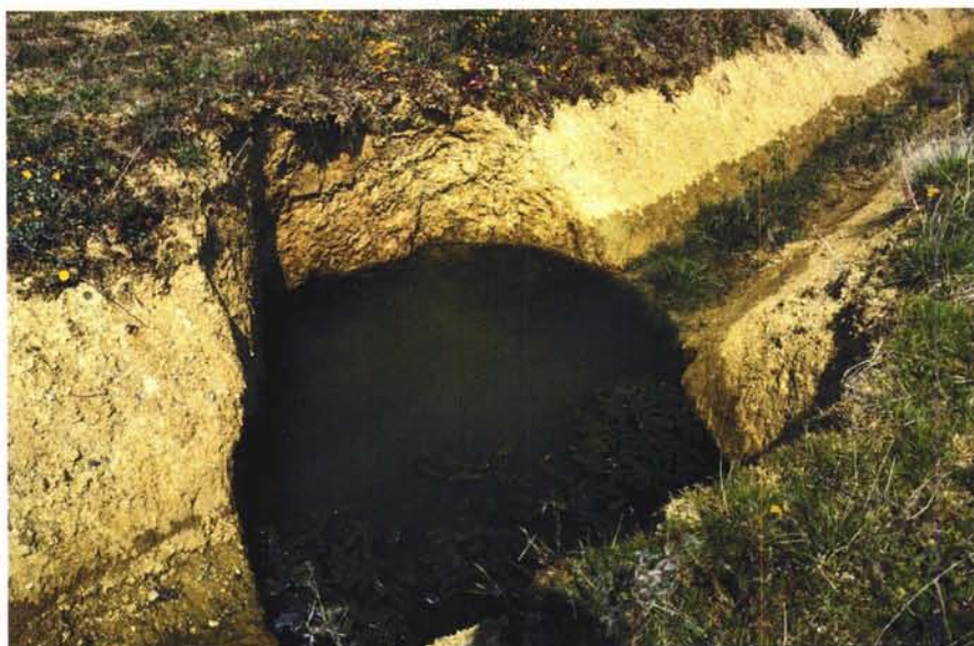
Photographie 33 – Marmite d'érosion dans le coursier en terre d'un déversoir rustique.
