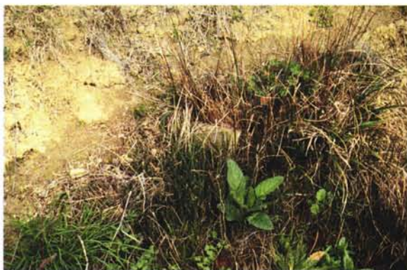
Photographie 22 – Exutoire de drain en partie masqué par une végétation herbacée. Il sera totalement phagocyté dans quelques mois.
