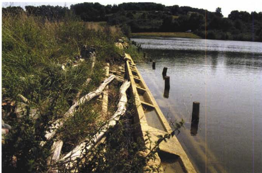
Photographie 13 – La photographie montre un exemple de confortement rustique sur un talus très dégradé par les vagues.
