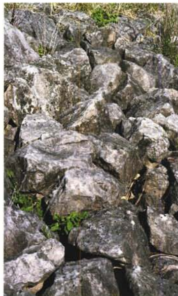
Photographie 12 – Un exemple de riprap de bonne blocométrie (enrochements calibrés, anguleux).
