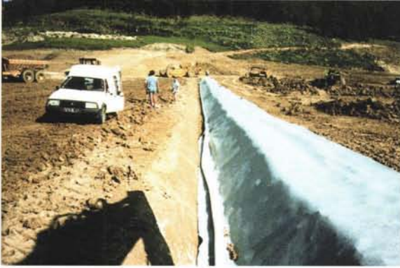
Photographie 1 – Mise en place du collecteur à la base du drain en géosynthétique.
