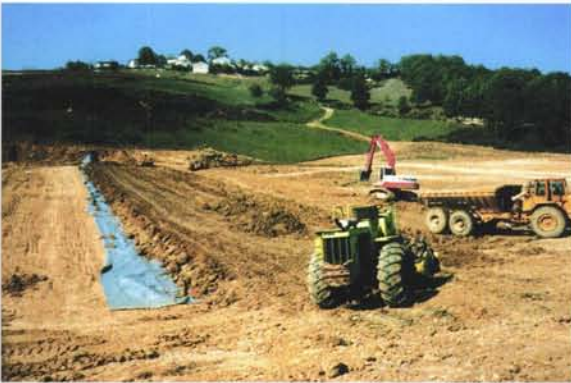
Photographie 2 – Compactage du remblai. On remarquera sur la photographie le foisonnement des terres en bordure du massif compacté.
