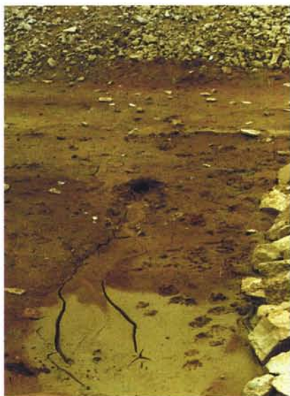
Photographie – 45 Barrage de GOURDON (Lot). La photographie montre l'un des « renards » au pied amont du barrage.
