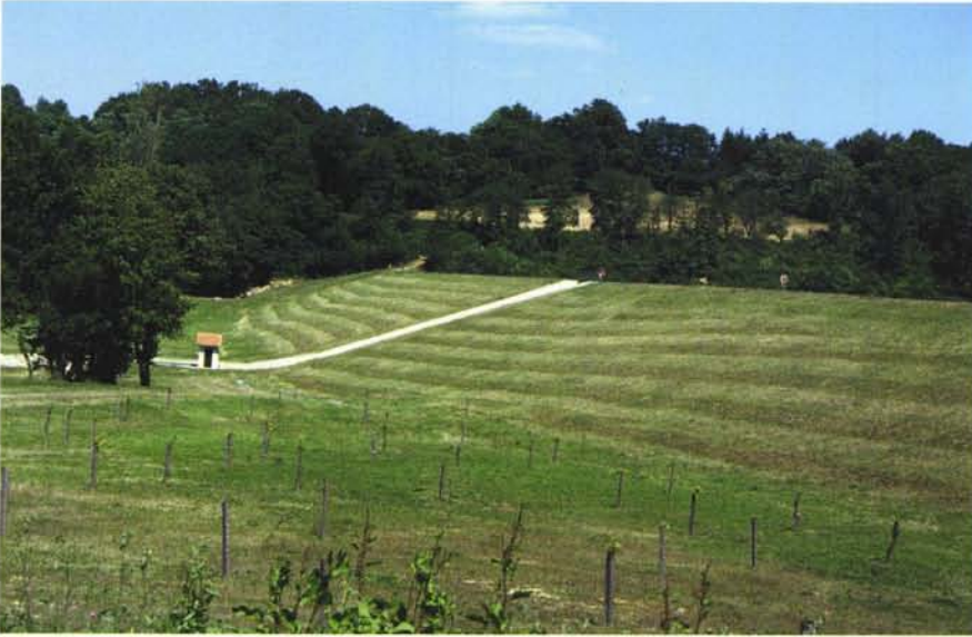
Photographie 14 – Un barrage bien entretenu.
