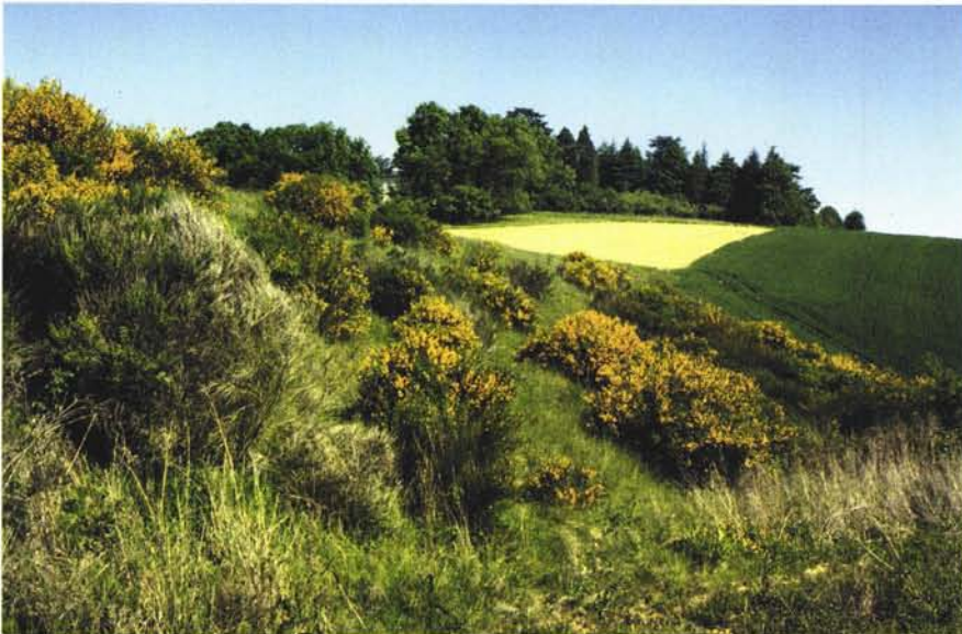
Photographie 15 – Ouvrage négligé. Remarquer la forte densité de genêts et d'ajoncs sur le talus aval.
