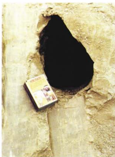
Photographie 48 – Barrage de BUGET (Haute-Garonne). Le renard vu de l'aval.
