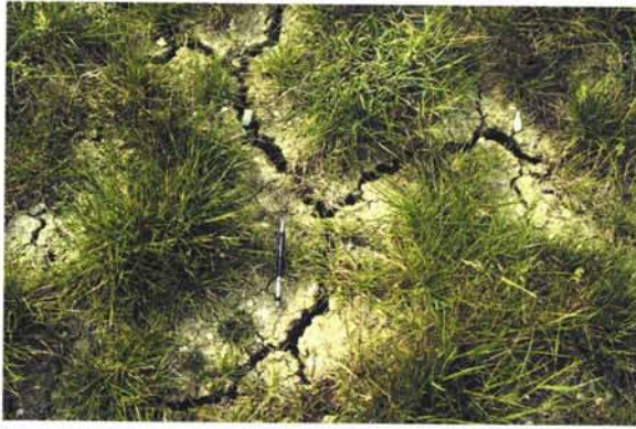
Photographie 4 – Fissure de retrait en mosaïque.
