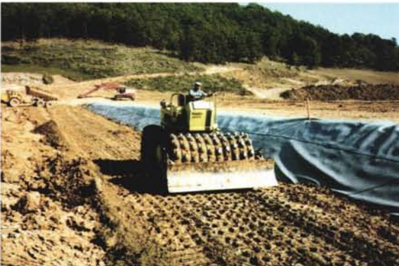
Photographie 3 – Cette photographie illustre les difficultés de mise en place des sols contre le géosynthétique avec un compacteur classique.
