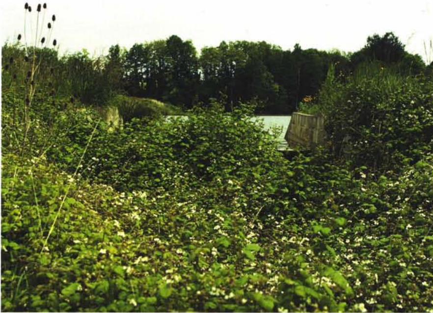
Photographie 18 – Evacuateur de type mixte. Le coursier est envahi par les ronces.
