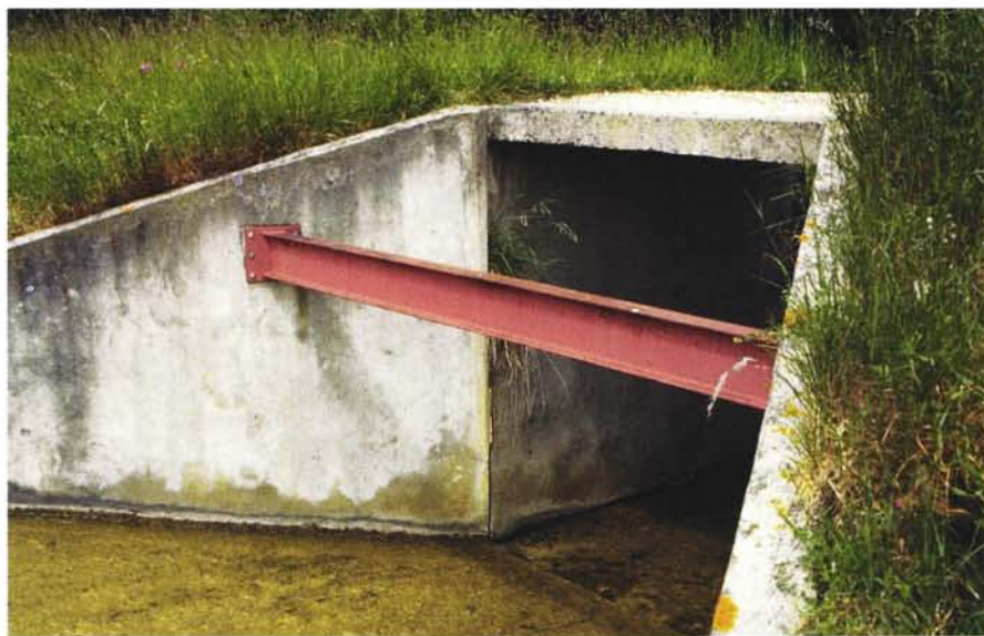
Photographie 31– La photographie montre le confortement d'un déversoir en béton par des tirants qui maintiennent l'écartement des bajoyers à l'entrée de l'ouvrage.
