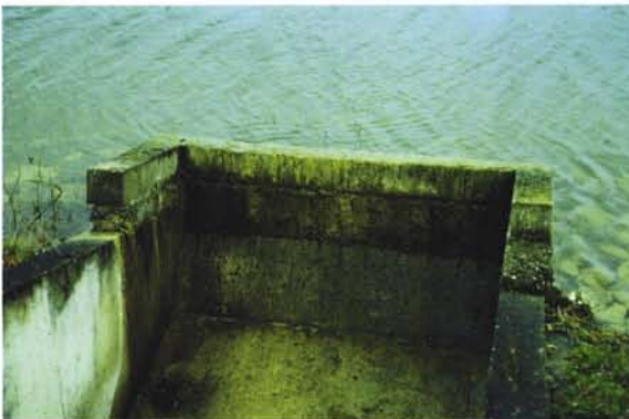
Photographie 36 – Un exemple de rehausse du seuil déversant par deux rangées de parpaings.
