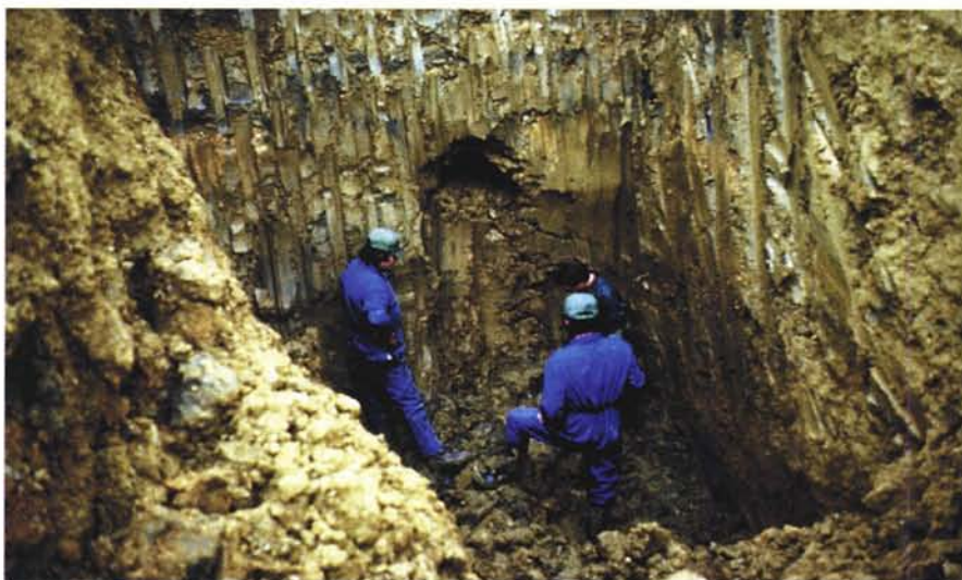
Photographie 48 – Barrage de BUGET (Haute-Garonne). Le renard vu de l'aval.
