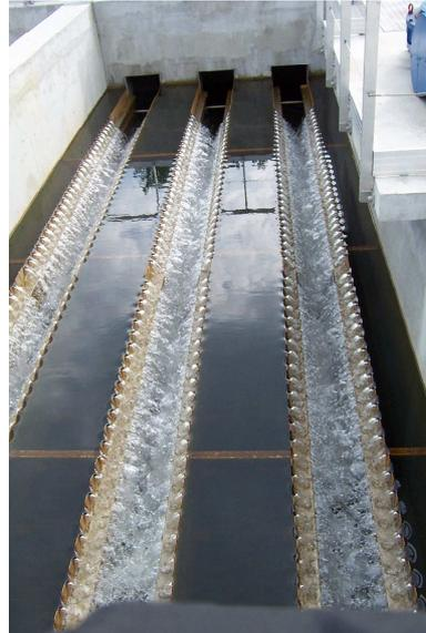
Photo : Décanteur lamellaire en fonctionnement vue de dessus
