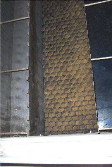
Photo : Blocs lamellaires vue de dessus (ouvrage vide)
