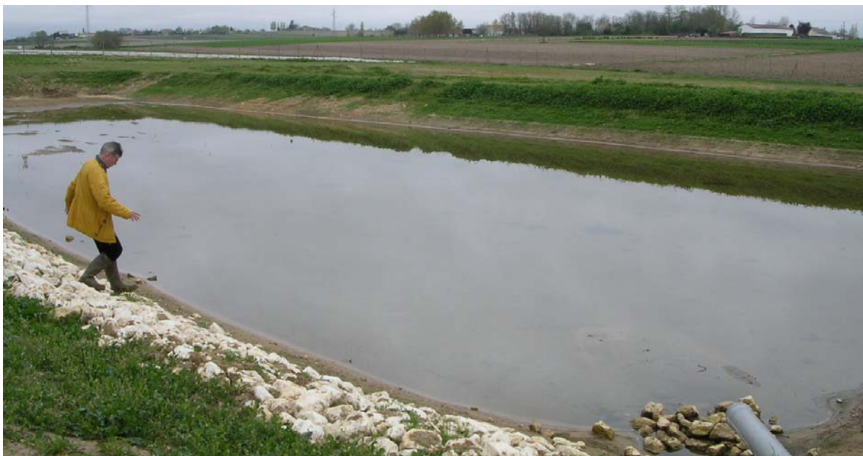
Figure 4. Observation de l'état du bassin 3, 5 mois après la mise en eau
