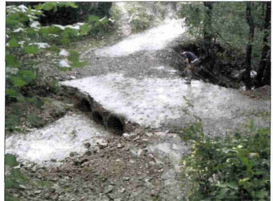
Gué sur le ruisseau de Cartaou après l'intervention d'une entreprise pour déboucher les buses (23 octobre 2006)
