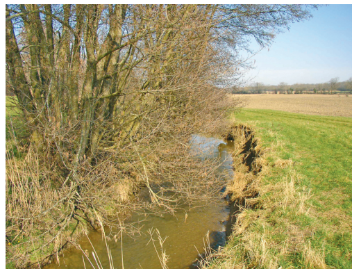
▲ Photo 1 – Bande enherbée en bordure de cours d'eau.
