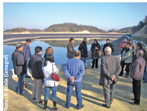
◀ Photo 3 – Réserve de transfert inter-bassin.
