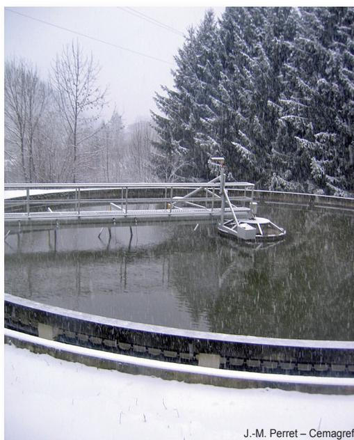
Dans l'avenir, les installations fonctionnant sur ce type de configuration devront donc être équipées d'une zone de contact, d'un poste fixe de chloration (voir d'apport de lestant), et d'un clarificateur dimensionné avec sécurité afin de pouvoir faire face à des foisonnements systématiquement déclenchés par l'à-coup de charge.
