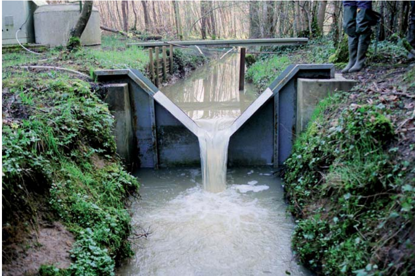
Seuil hydrométrique (mesure des débits) sur l'Orgeval, en forêt de Choqueuse (77)
