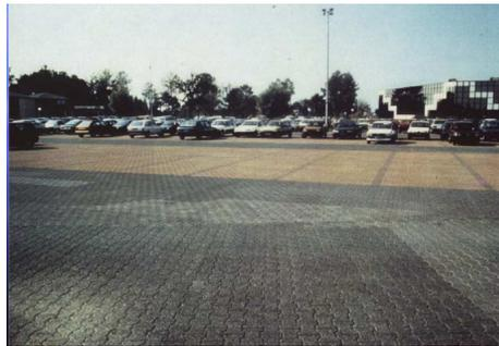
Figure 4.3. Exemple de chaussées réservoir réalisées à Bordeaux (Bourgogne, 2006)
