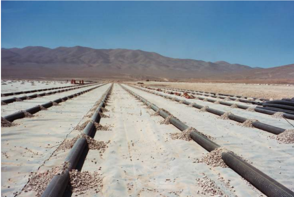
Figure 4. Tuyaux annelés en PEHD pour le drainage d'une zone d'extraction de métaux (d'après Touze-Foltz et al., 2008)
