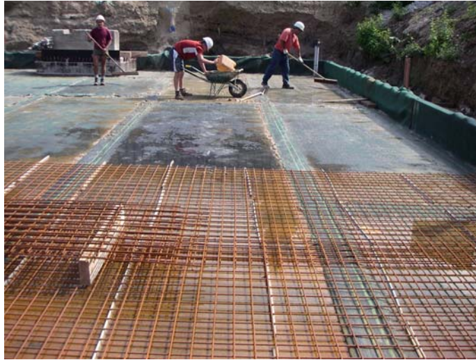
Figure 1. GSB en attente avant réalisation du radier
