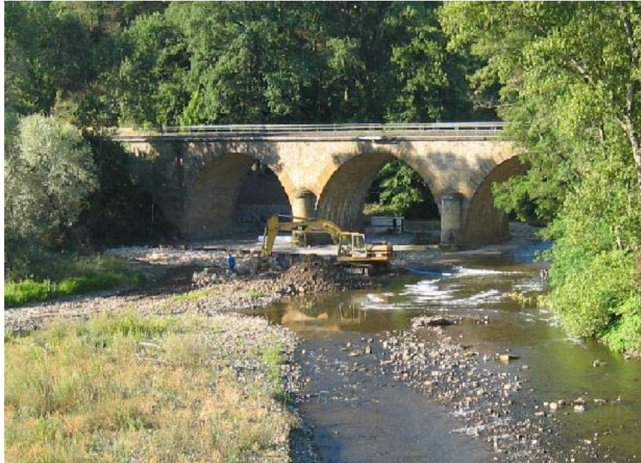
Travaux en rivière. Photo G. Bouleau
