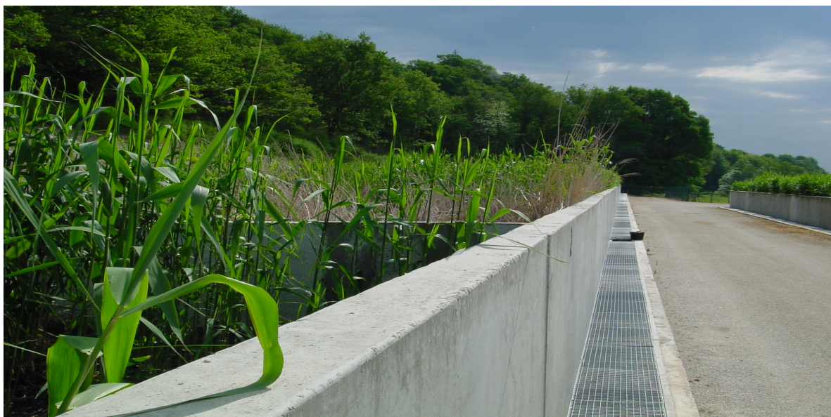
Photo : Filtres plantés de roseaux
