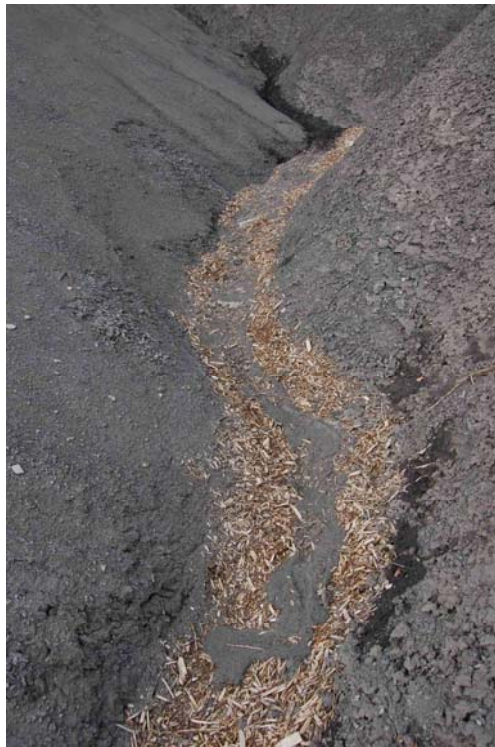
Figure n°9 - Exemple de coulée de sédiments en fond de rigole
