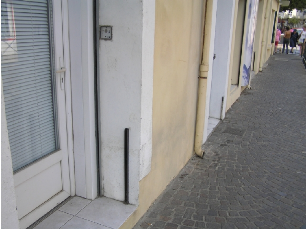
FIG. 9.18 – Suite de batardeaux dans le centre ville de Sérignan
