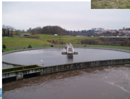
Clarificateur d'une boue activée
