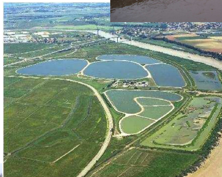
Lagunage (Source : STEP de Rochefort)
