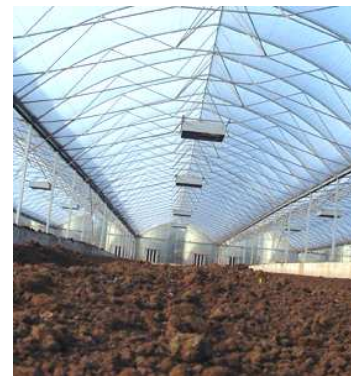
Serre de séchage solaire – (Source ADEME)
