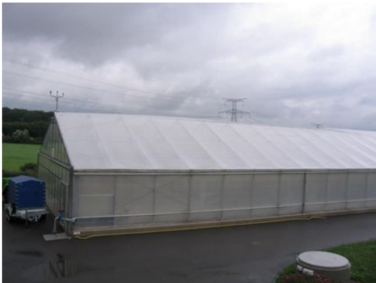
Photo 2 : Serre fermée à Folschwiller (57)
