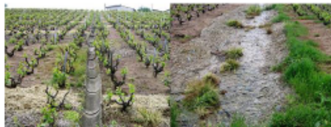
10 Demi-buses et chenal ouvert bétonné
