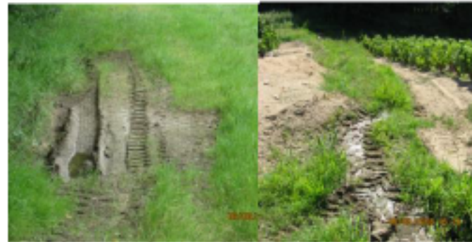
5. Ornières localisées et ornières formant court-circuit
