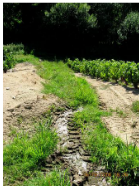
Ornières formant court-circuit
