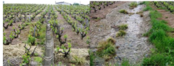
10 Demi-buses et chenal ouvert bétonné
