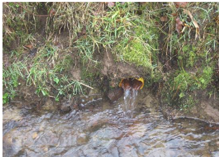
J.J. Gril Cemagref Drain primaire (faible diamètre)
