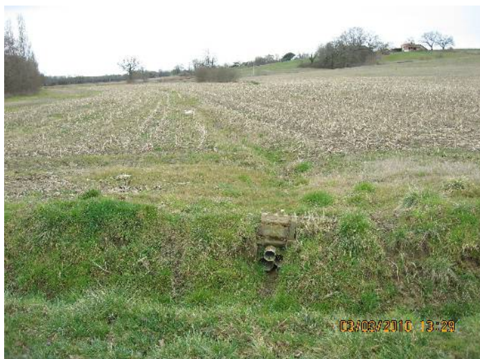
G. Le Hénaff Cemagref Bande enherbée court-circuitée par un collecteur
