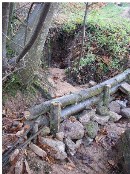
Photo 14 : aménagement destiné à disperser un ruissellement concentré dans le Beaujolais Au centre, barrage destiné à la correction de la ravine ; à gauche, début de fascine en branchages destinée à disperser le ruissellement après remontée du niveau
