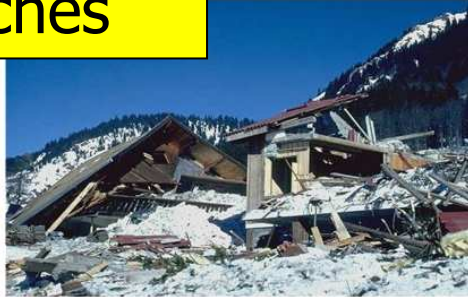
Dégâts d'avalanche damages (Cemagref)
