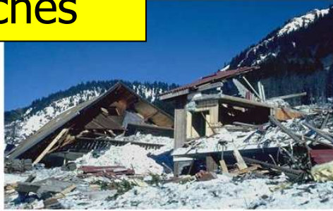
Dégâts d'avalanche damages (Cemagref)
