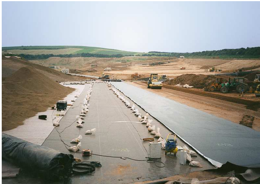
Figure 1 – Visualisation des différents composants des barrières actives et passives, de gauche à droite : matériau granulaire drainant, géotextile antipoinçonnant, géomembrane, étanchéité passive
