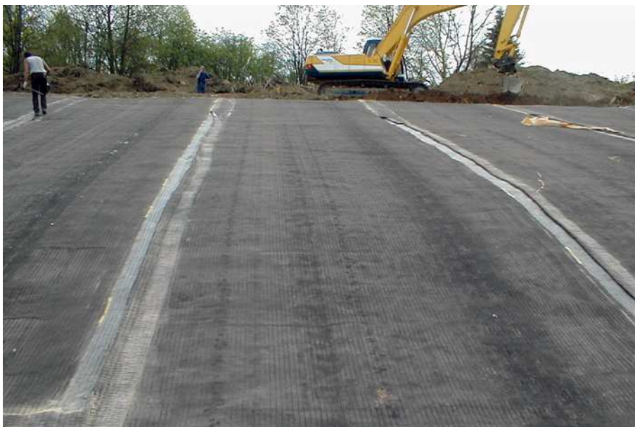
Figure 22 – Illustration sur talus de la pose selon la ligne de plus grande pente
