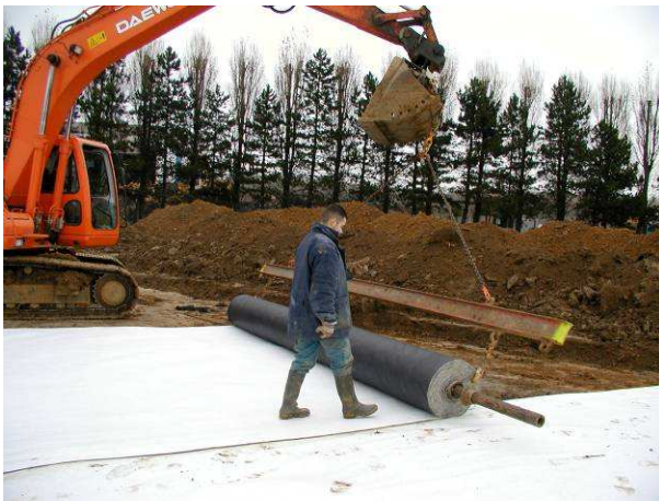
Figure 20 – Illustration du déroulage et du contrôle de la largeur de recouvrement
