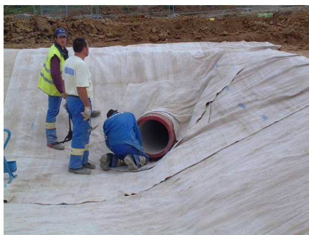
Figure 22 – Illustrations de recouvrements autour de traversées d'étanchéité
