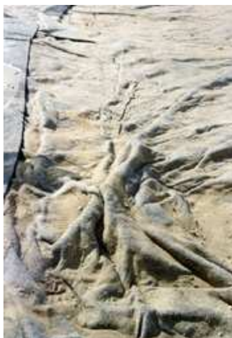
Figure 1 – Mise en tension de GSB et géomembrane sur talus. Etat de sol support non recevable pour la pose d'un GSB (photo T. Gisbert)
