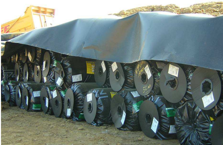
Figure 14 – Visualisation d'une protection complémentaire possible des rouleaux correctement emballés, stockés et étiquetés
