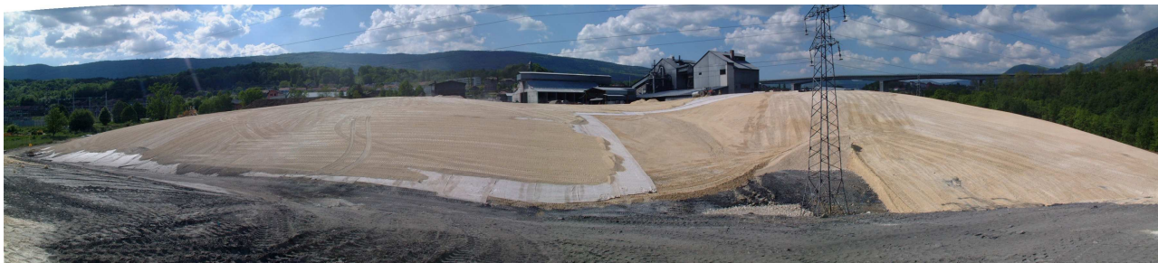
Figure 5 – Illustration de l'utilisation d'un GSB en couverture
