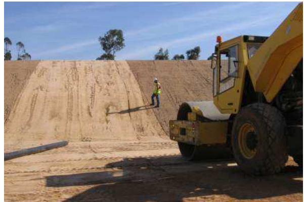
Figure 13 – Illustration d'un mauvais et d'un bon état de surface sur pente (d'après Touze-Foltz et al. (2008))
