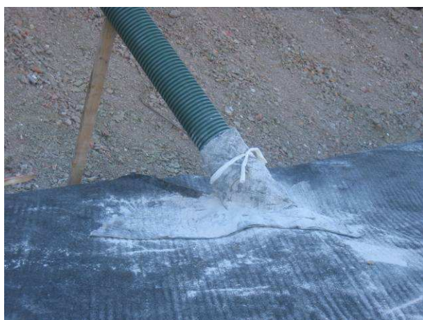
Figure 22 – Illustrations de recouvrements autour de traversées d'étanchéité
