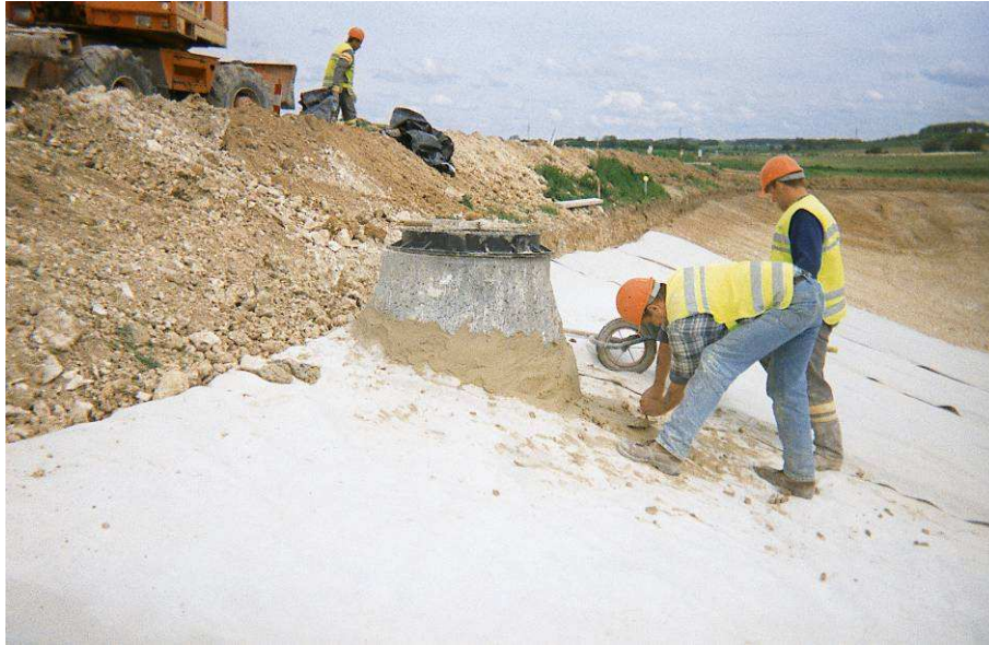
Figure 23 – Illustration de la mise en place de noyau d'argile en partie supérieure d'étanchéité autour d'une cheminée
