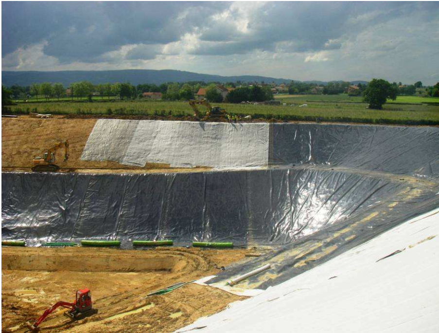
Figure 3 – Lés de GSB déroulés de façon désordonnée (photo T. Gisbert)
