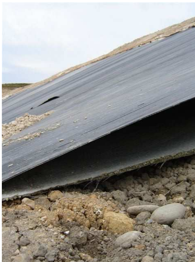
Figure 1 – Mise en tension de GSB et géomembrane sur talus. Etat de sol support non recevable pour la pose d'un GSB (photo T. Gisbert)
