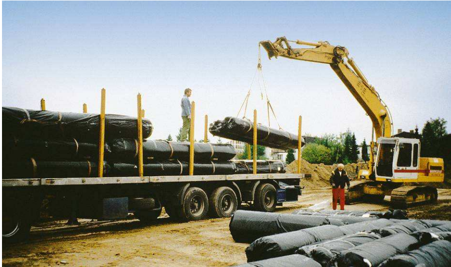
Figure 16 – Déchargement des rouleaux avec du matériel adapté
