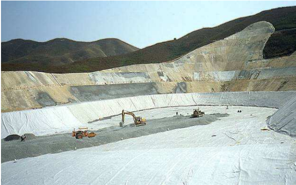
Figure 26 – Déplacement des engins sur une surface préalablement confinée et protégée.
