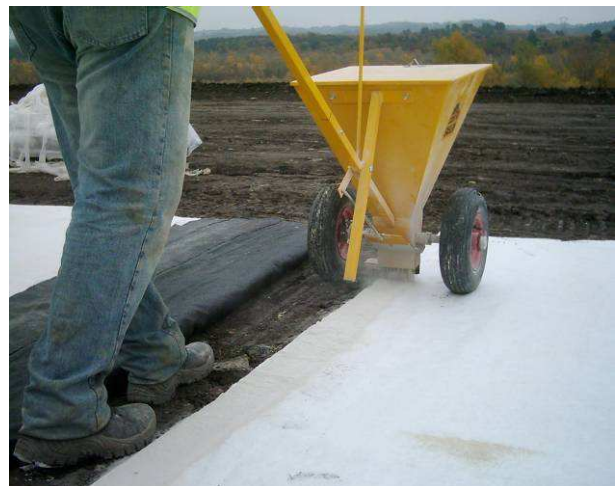
Figure 18 – Apport de bentonite (a) en pâte et (b) en poudre
