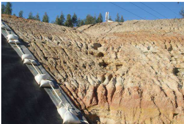
Figure 13 – Illustration d'un mauvais et d'un bon état de surface sur pente (d'après Touze-Foltz et al. (2008))
