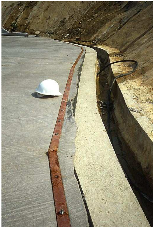
Figure 32 – Illustration de l'utilisation d'un réglet métallique
