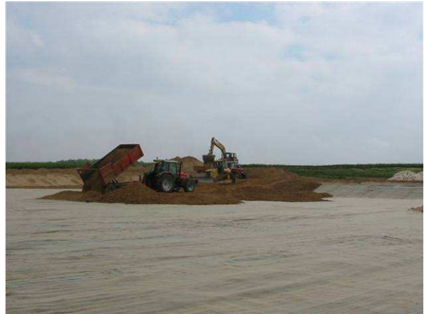
Figure 26 – Déplacement des engins sur une surface préalablement confinée et protégée.
