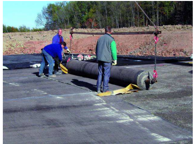
Figure 20 – Illustration du déroulage et du contrôle de la largeur de recouvrement
