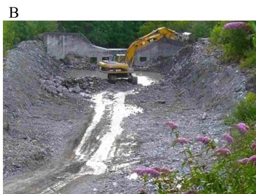
Figure 2. (A) Schéma de principe d'une plage de dépôt (Van Dine, 1996) ; (B) opération de curage mécanique d'une plage de dépôt sur un torrent isérois (photo : Pascal Diot)
