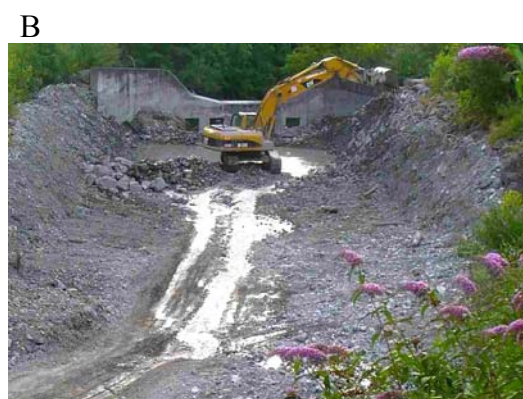
Figure 2. (A) Schéma de principe d'une plage de dépôt (Van Dine, 1996) ; (B) opération de curage mécanique d'une plage de dépôt sur un torrent isérois (photo : Pascal Diot)
