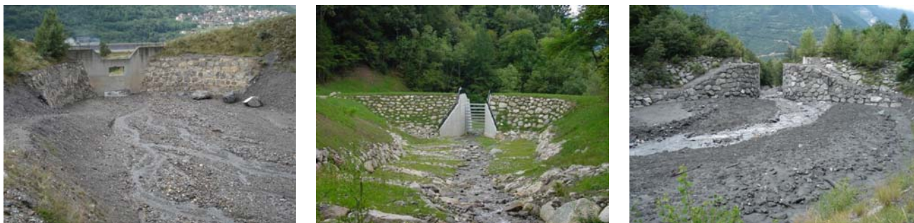
Figure 3. Ouvrages terminaux de plages de dépôts de différents types et de perméabilité faible, moyenne et forte, en allant respectivement de gauche à droite (photos : Christophe Peteuil)
