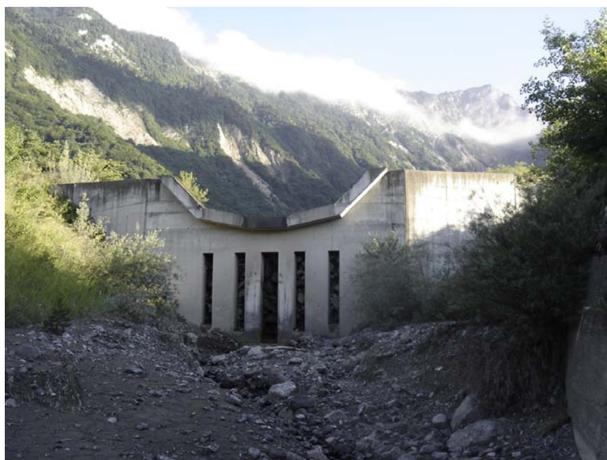
Figure 19. Barrage de sortie de la plage de dépôt du Manival (photo : Frédéric Liébault)
