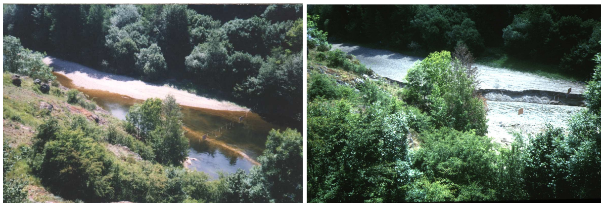
Figure 8 : exemple d'érosion régressive dans le remous de l'ancien barrage de St Etienne du Vigan (type Figure 4). Un « canyon » s'est creusé très rapidement sous l'effet de l'érosion régressive puis le reste des matériaux a été érodé par érosion latérale (repère visuel : le câble avec panneaux).
