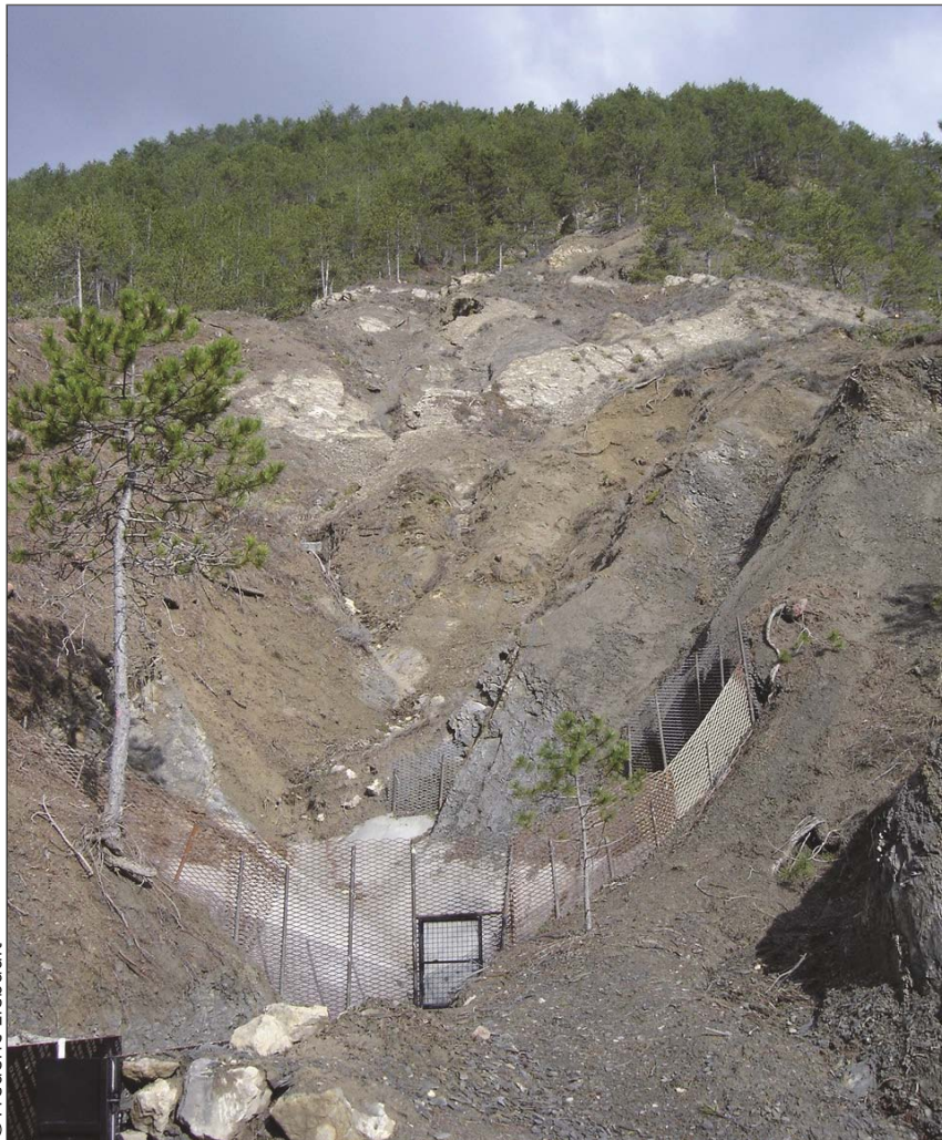
La ravine d'Ausson après les travaux de déboisement
