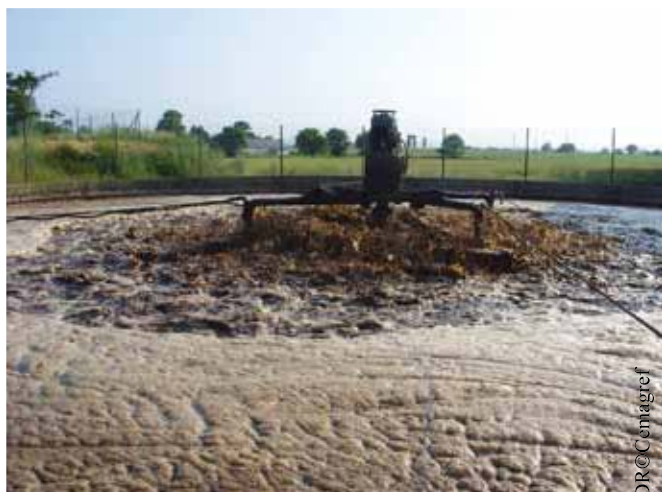
Traitement du lisier par digestion aérobie
