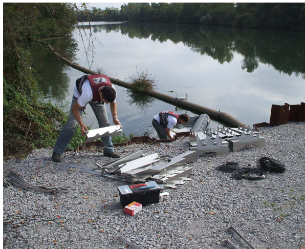
Photo 9 : Montage de la barrière à infrasons de l'usine de Biron
