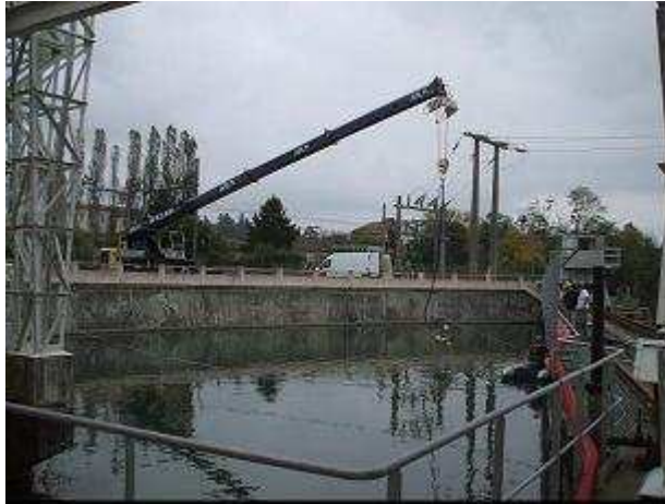
Photo 5 : Mise à l'eau des répulseurs à infrasons dans la chambre d'eau de l'usine de Baigts
