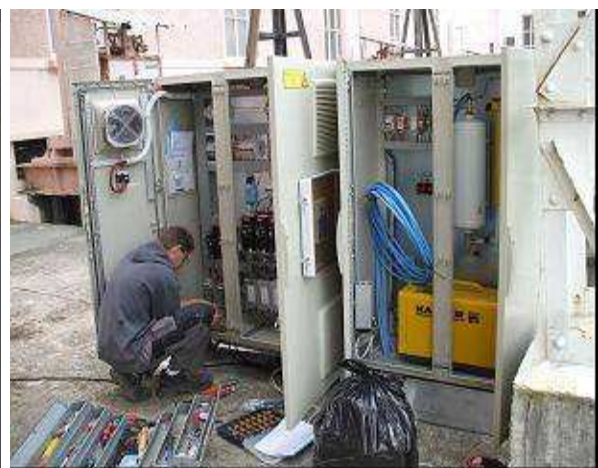
Photo 2 : Armoires de commande des émetteurs à infrasons. A gauche : générateur de fréquence. A droite : régulateur de pression d'air dans les émetteurs
