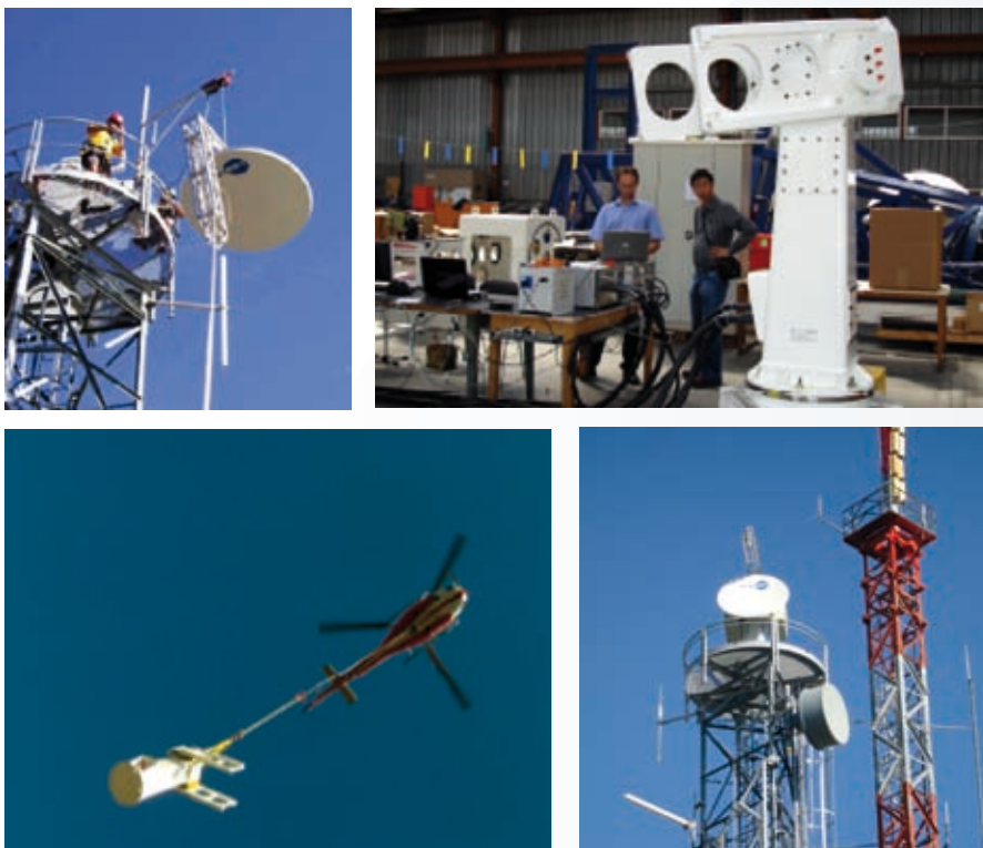
Figura 3.4 - Sostituzione ed installazione del posizionatore. Figure 3.4 - Remplacement et installation du positionneur.
