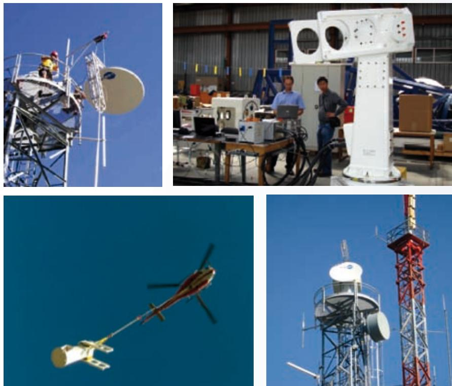
**Figura 3.4** - Sostituzione ed installazione del posizionatore.
