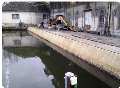
Un exemple de prise d'eau équipée d'un plan de grilles à faible espacement libre entre barreaux : l'ouvrage de Chamberlane testé sur la Dronne
