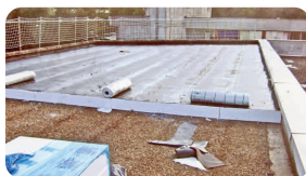
Isolation du toit ■ Gwénola Rey
