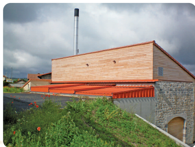
Chaufferie au bois-énergie
