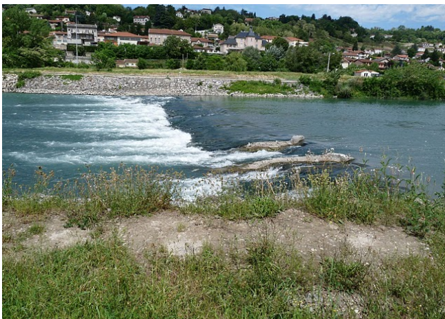
Figure 11: Photo du seuil sur le Canal de Miribel Amont (SM2)
