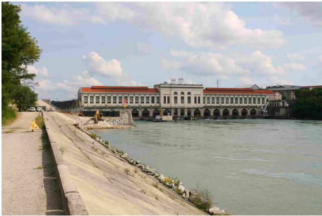
Figure 7: Usine hydroélectrique de Cusset
